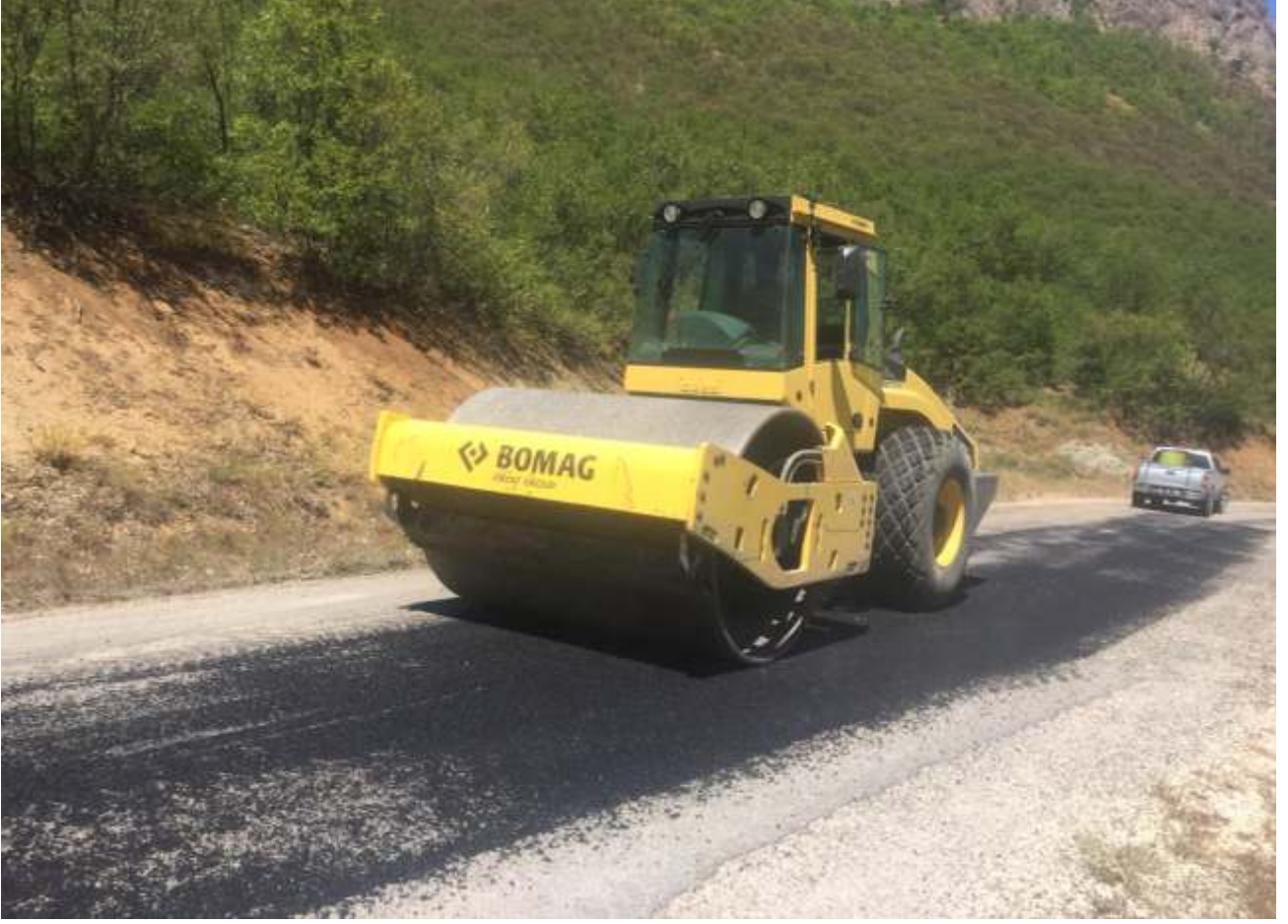
Baylık KYY.'da 5 Km Asflat Onarım Çalışmamız Tamamlanmıştır.
