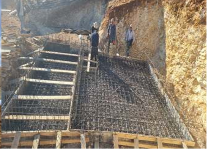
Şekil 2 MERKEZ-SİNAN İÇMESUYU DEPOSU DEMİR BAĞLANTISI
