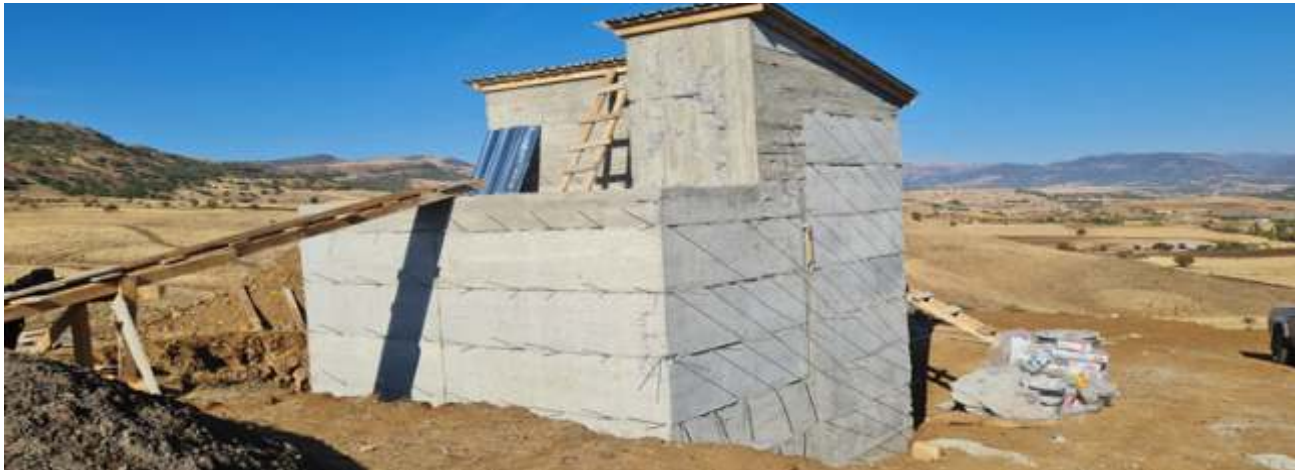
MERKEZ-BURMAGEÇİT KÖYÜ İÇMESUYU DEPOSU
