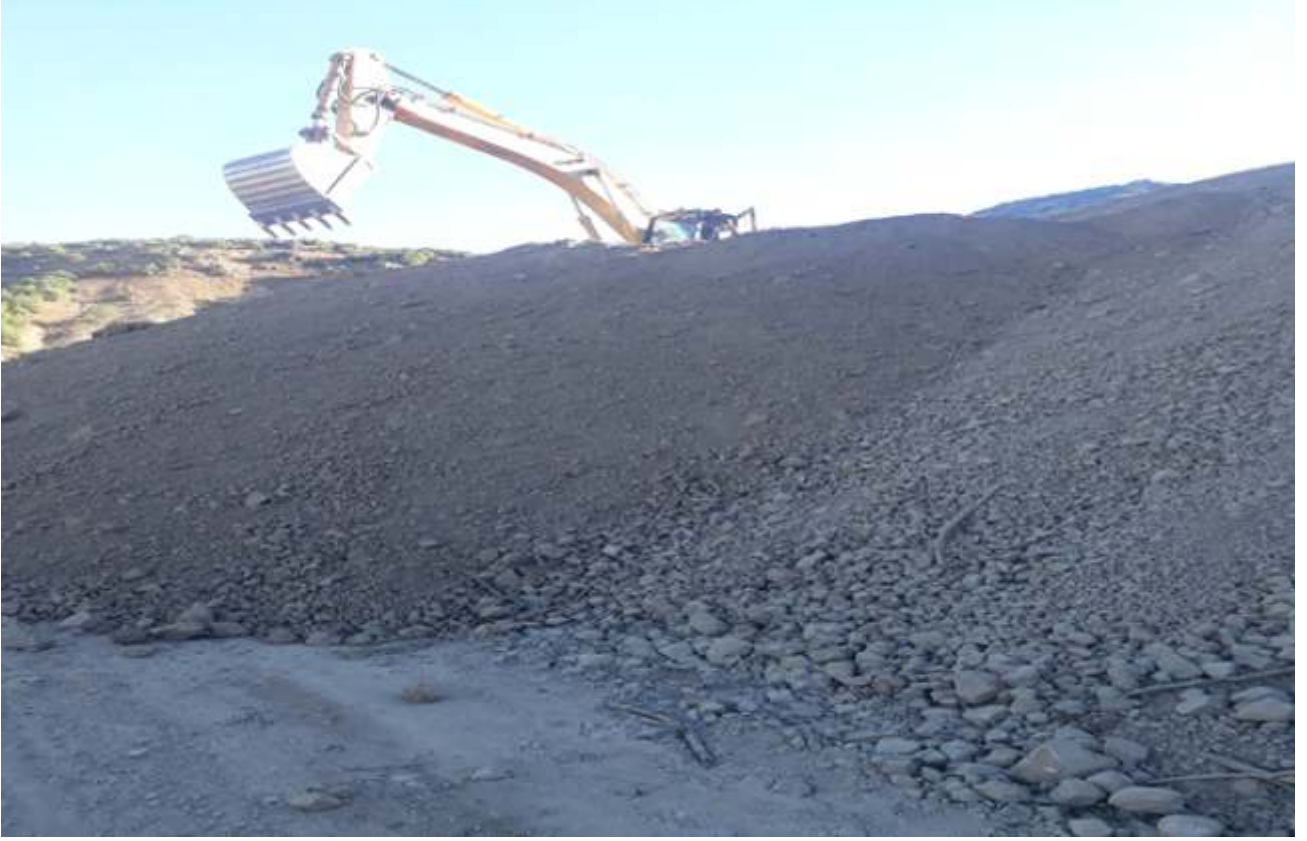
Kalaycı KYY'da Yol Onarım Onarım Çalışmamız Tamamlanmıştır.
