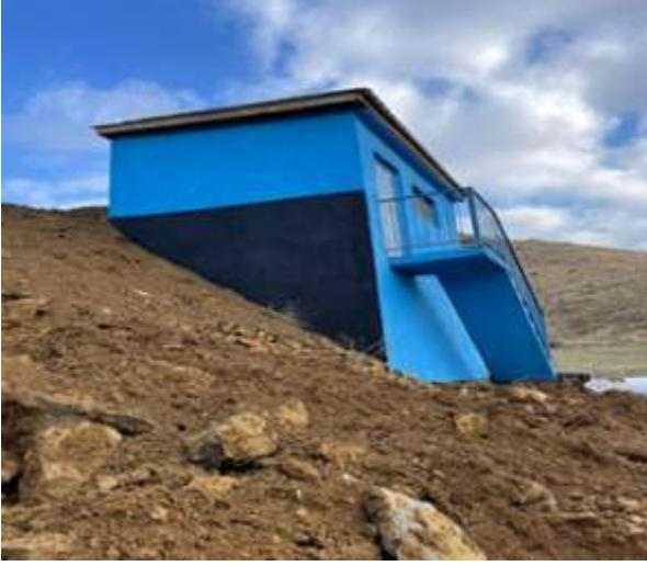
Şekil1 MERKEZ-ÇIRALI BOR KÖYÜ İÇMESUYU DEPOSU
