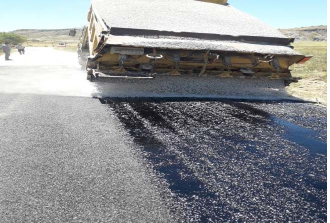
Yenidoğdu KYY.'da 3 Km 2. Kat Asfalt Çalışmamız Tamamlanmıştır
